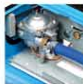
Подсоединение шланга к плите
